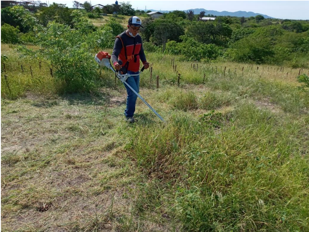
Figura 2A. Limpieza y preparación del terreno.
