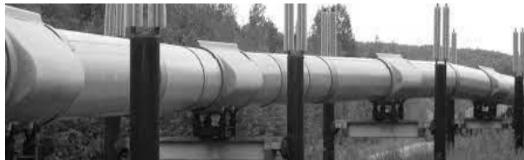
Figura 5: Se muestra la construcción del oleoducto (TASC, 2021).
