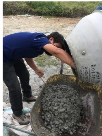
Figura 14 Obtención de mezcla de hormigón
