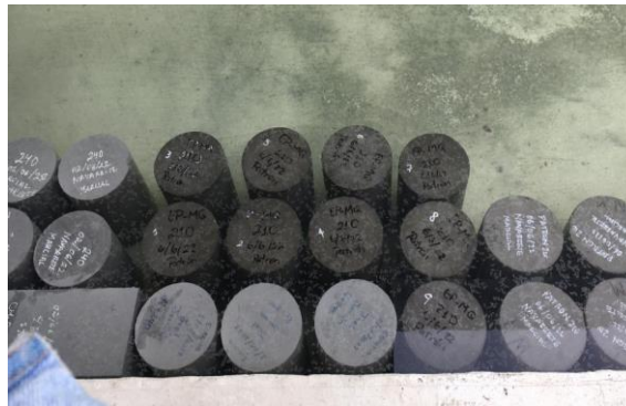
Figura 19 Curado de probetas de hormigón
