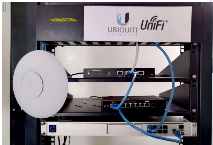
Anexo 9. Equipos Ubiquiti en rack del laboratorio de telecomunicaciones.
