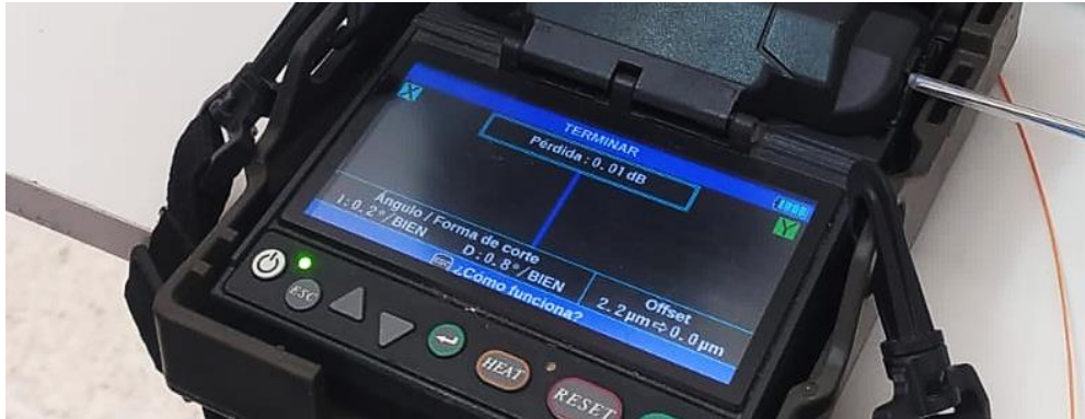
Figura 4.25. Prueba de atenuación de empalme de fibra en la práctica.
