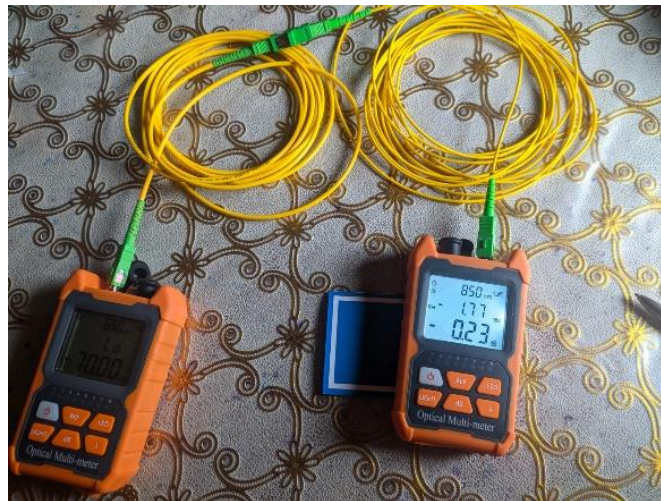
Figura 4.24. Prueba de atenuación de Conector.
