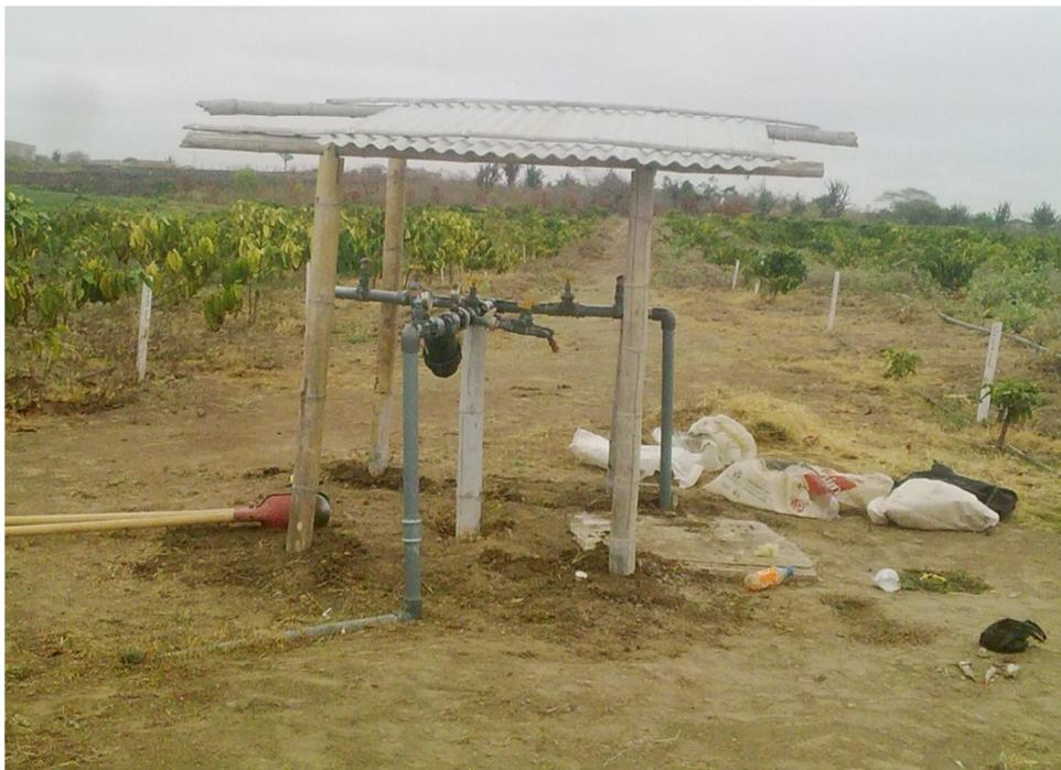
Figura 2A. Válvulas de riego
