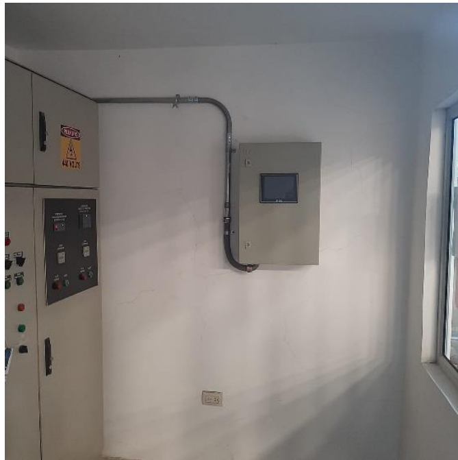
Figura 75. Instalación de tablero de control
