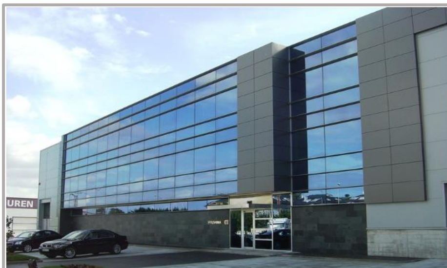
Figura 19 Edificio de acero estructural
