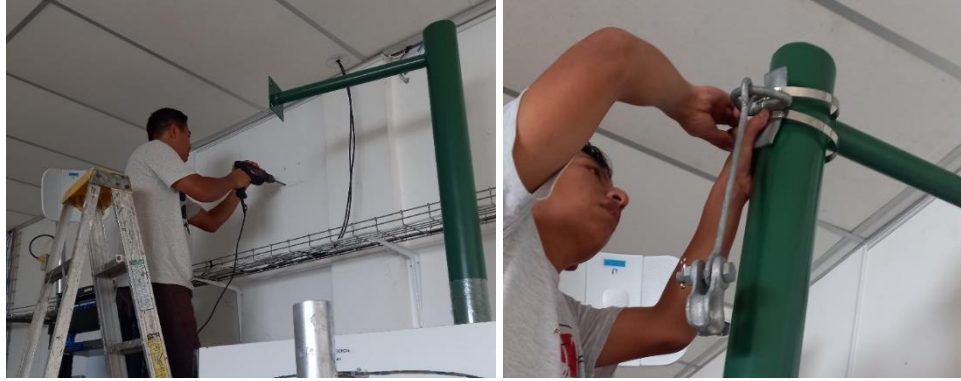
Anexo 1. Implementación de poste y herrajes.
