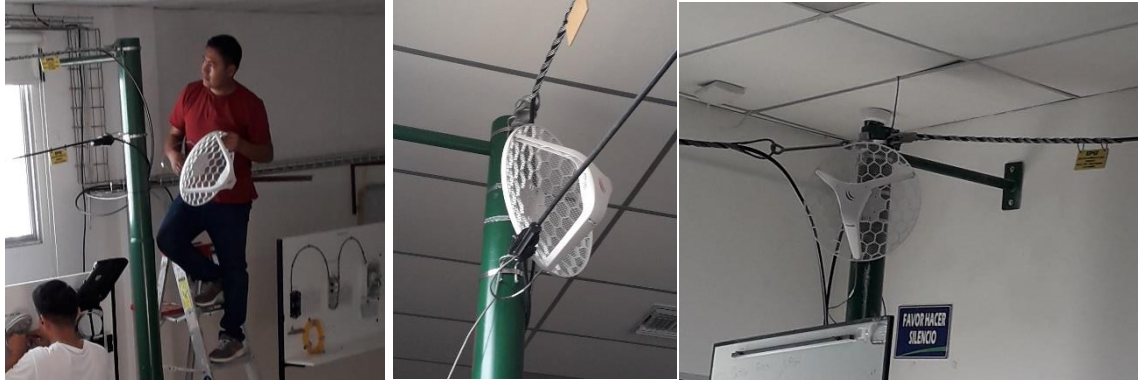
Anexo 6. Colocación de las antenas en los postes.
