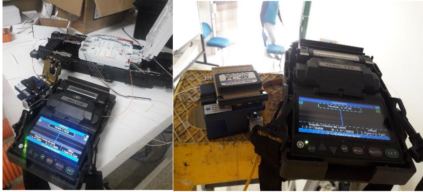
Anexo 4. Empalme de fibra óptica por fusión.
