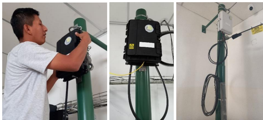
Anexo 3. Colocación y armado de NAPS.
