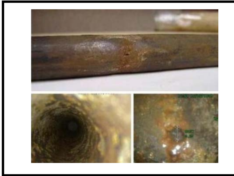
Figura. 13 Corrosión interna en tuberías
