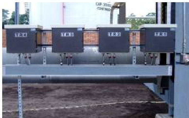
Foto 5 – Rectificadores para PC del Fondo de 4 Tanques de 20,000 bbls
