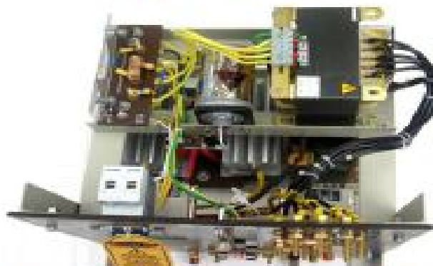
Foto 7 – Detalle Interior Rectificador Enfriado por Aire.
