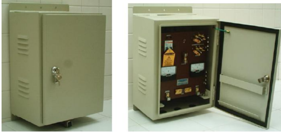
FIGURA 2.9: RECTIFICADORES PARA EL USO DE PROTECCION CATODICA POR CORRIENTES IMPRESAS.
