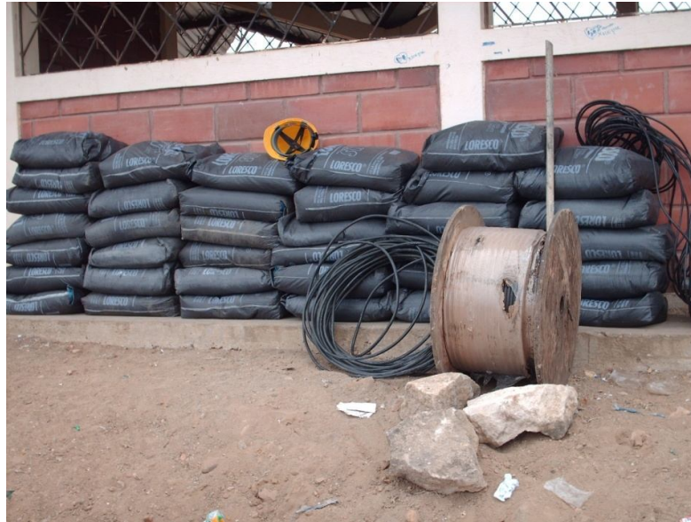
FIGURA 2.7: SACOS DE RELLENO BACKFILL
