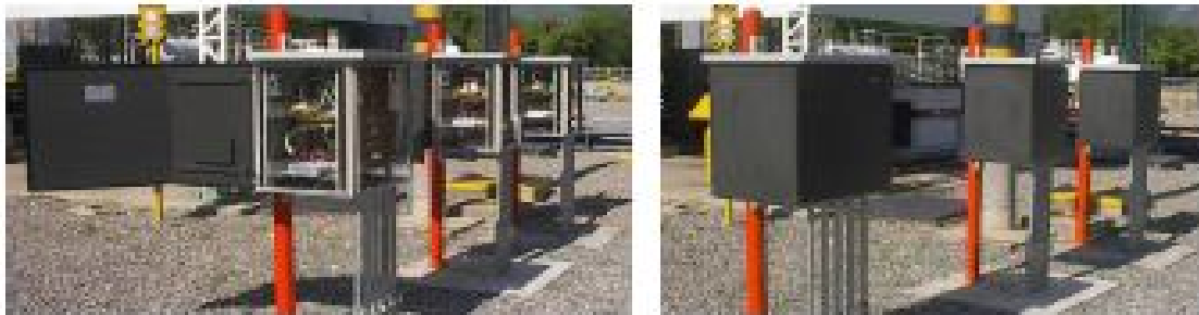
Foto 1 y 2 – Rectificadores con Gabinete Abierto y Cerrado en Petrobrás – Colombia.
