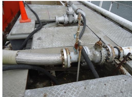
**Fotografía 23:** Válvula de paso segura
