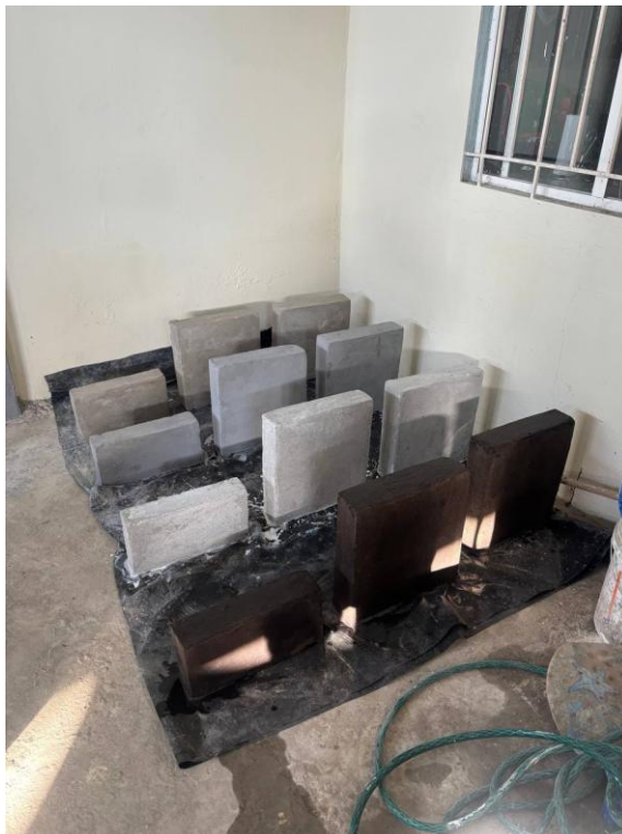
Figura. Imprimación de impermeabilizantes en los muretes.
