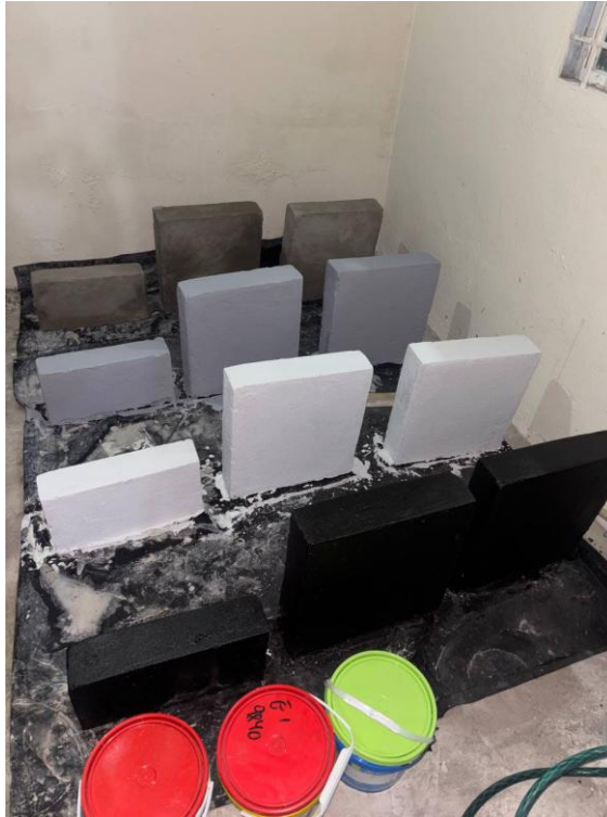
Figura. Aplicación de impermeabilizantes en muretes.
