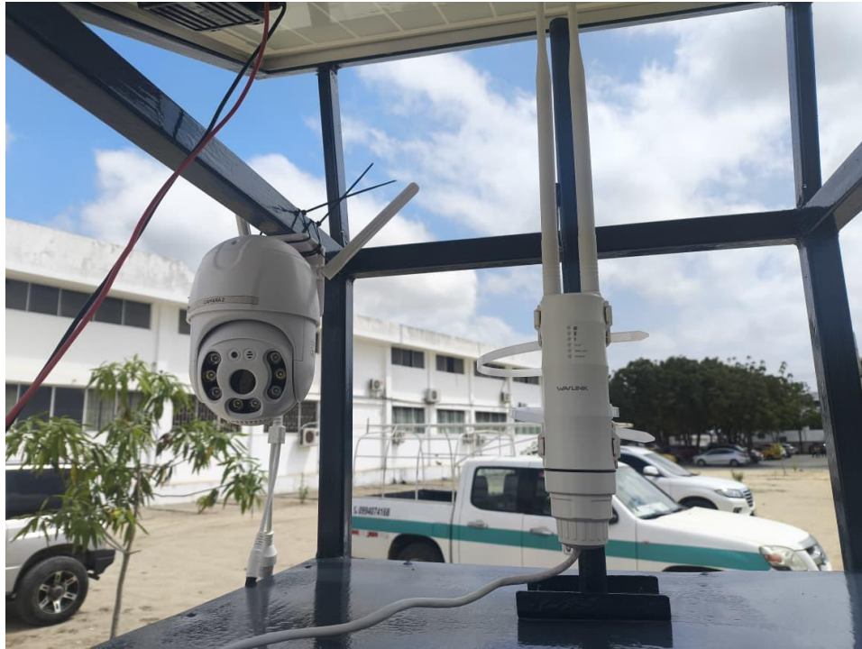
Figura 30: Instalación de la antena WAVLINK AC600 y de la cámara de seguridad
