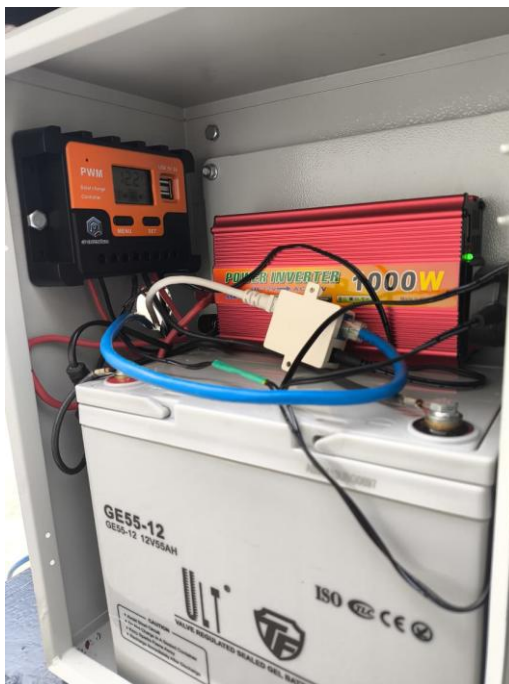
Figura 32: Tendido de conexiones hacia el regulador
