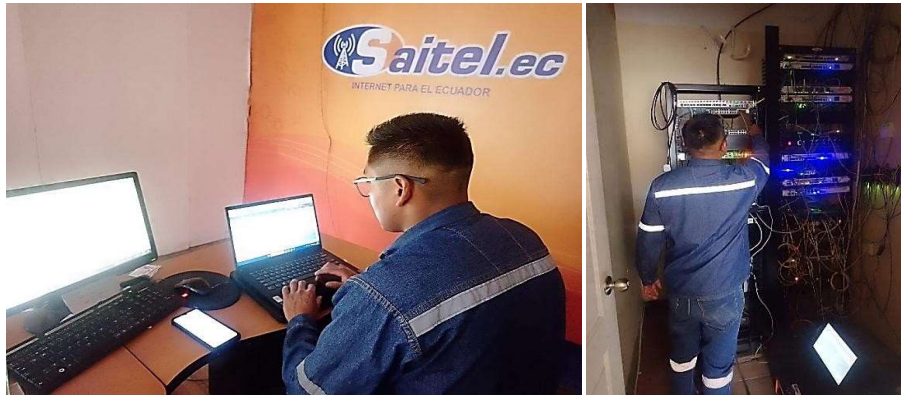
Figura 44. Realización de pruebas en la red de la Empresa SAITEL
