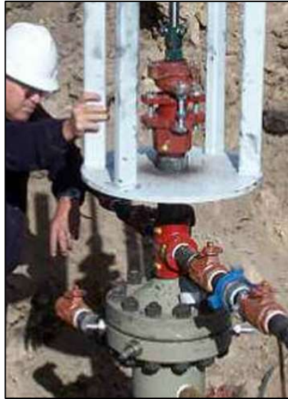
Figura 14. Mantenimiento del LRP, (UNICO, 2015).
