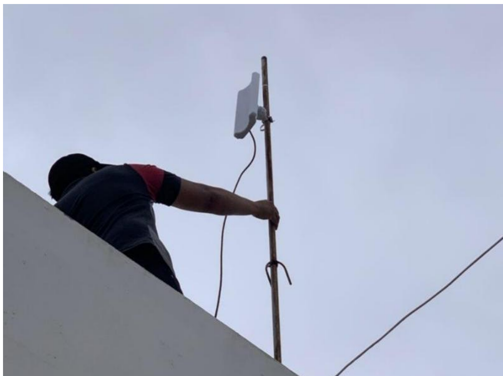
Figura 43. Instalación de la antena
