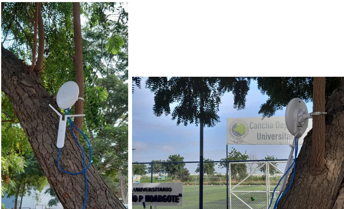
Figura 46. Instalación de las antenas para la conexión híbrida en la cancha sintética de la Universidad
