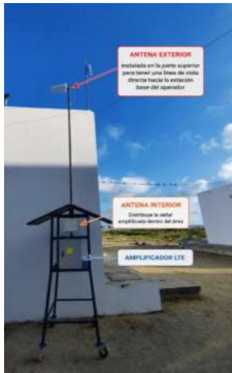
Figura 43. Vista del amplificador integrado en la estructura modificada
