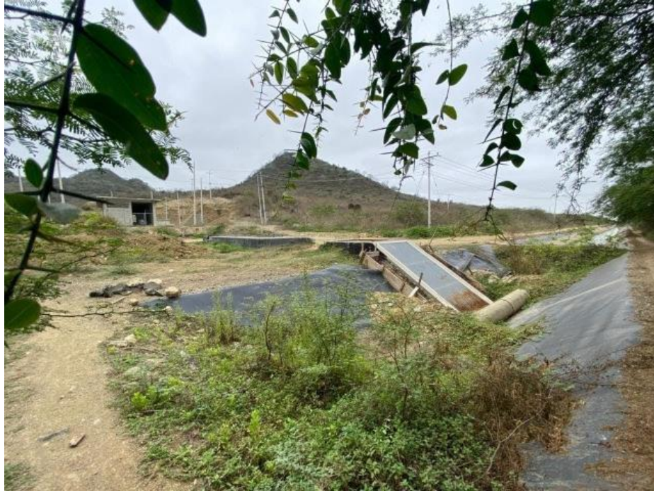
Anexo A.9. Fotografías de Estructura de captación que deriva el caudal del canal San Vicente al sistema de tratamiento de agua potable sin afectar el flujo al embalse de Cola.
