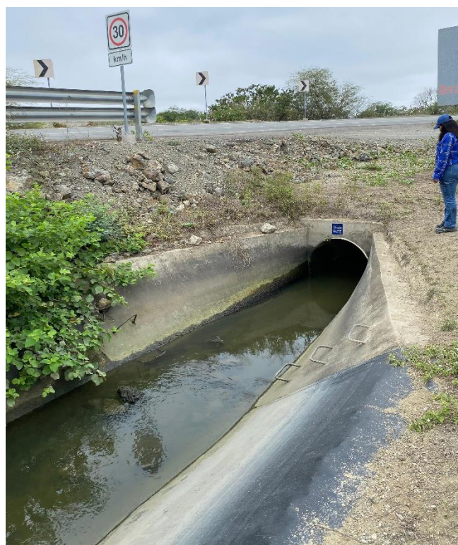
Anexo A.4. Fotografía del canal abierto de conducción proveniente de la Presa San Vicente, donde se observa un nivel crítico de caudal.
