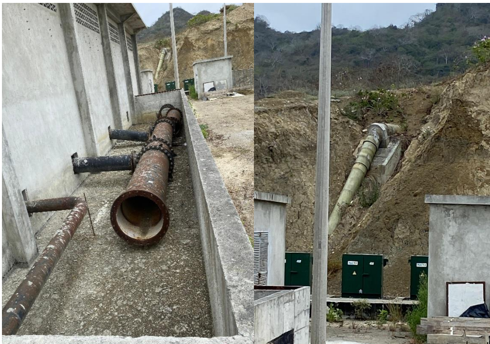
Anexo A.10. Tuberías del sistema de agua potable en proceso de integración hidráulica para conducción del caudal hacia la planta de tratamiento.
