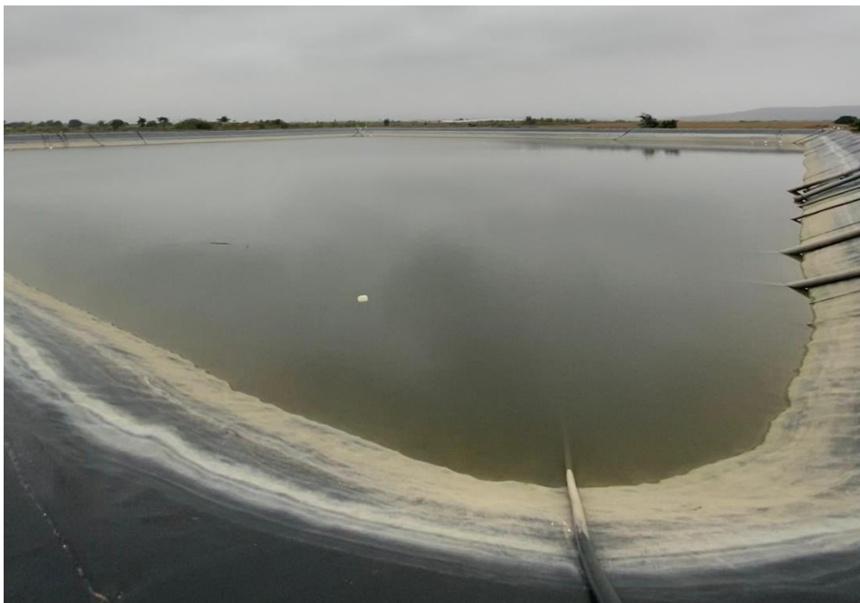
Anexo A.8. Fotografía de la vista general de uno de los once reservorios abastecidos mediante una tubería cerrada proveniente de la Presa San Vicente.
