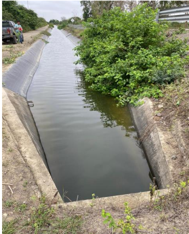
Anexo A.4. Fotografía del canal abierto de conducción proveniente de la Presa San Vicente, donde se observa un nivel crítico de caudal.
