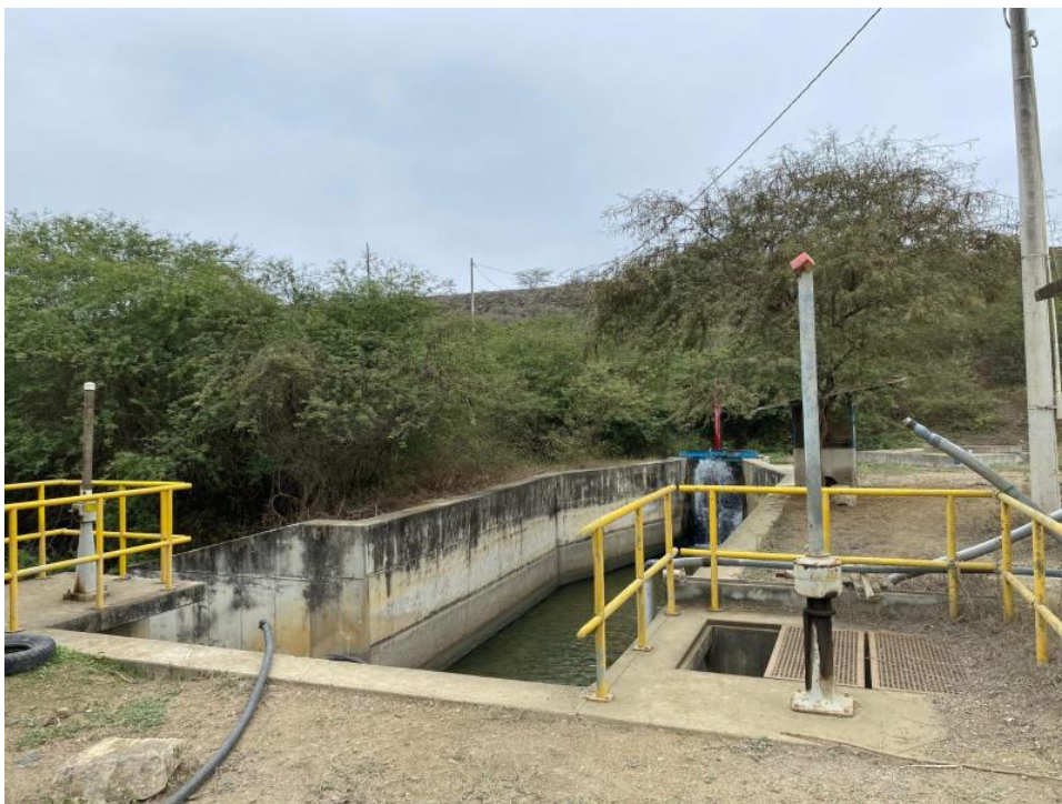
Anexo A.2. Fotografía de Estructura de control hidráulico (Apertura de compuertas en la descarga de salida de la Represa San Vicente)
