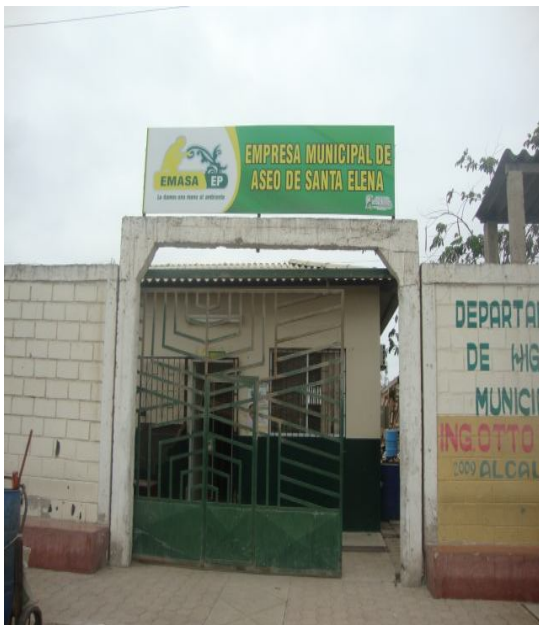
Exteriores de EMASA EP
