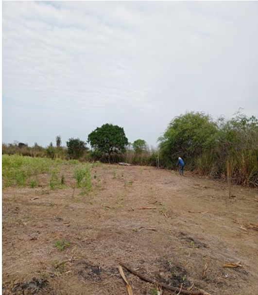
Figura 1A. Limpieza del terreno.
