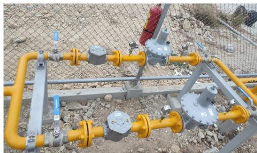
Ilustración 29 Tren de gases
