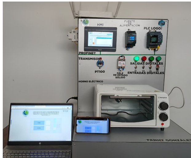
Figura 48: Prueba 1: Alarmas-HMI-Servidor. Fuente: Autor.
