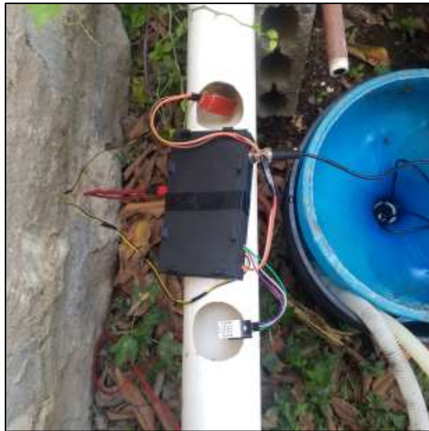
Figura 41: Previa instalación y colocaciones sensores
