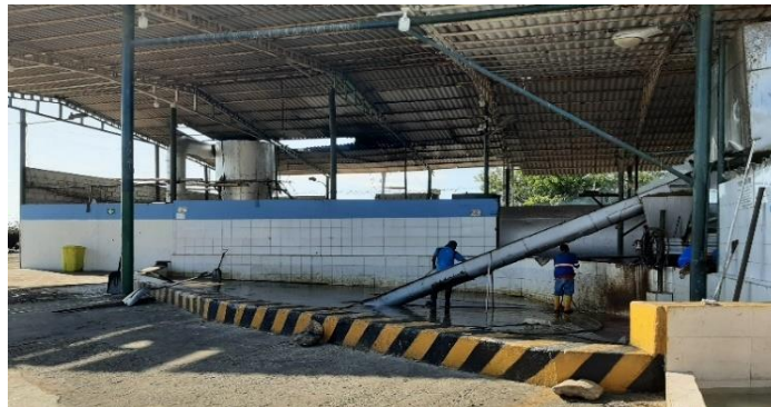
Imagen 1. Poza de recepción de materia prima
