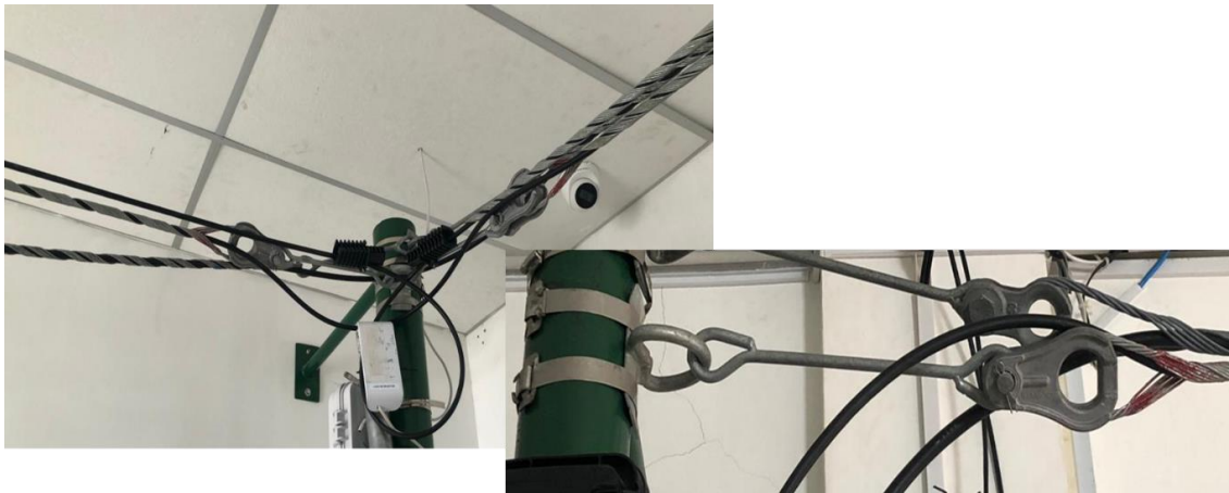
Figura 4.10. Instalación de Fibra ADSS de 48 y 24 hilos en postes metálicos
