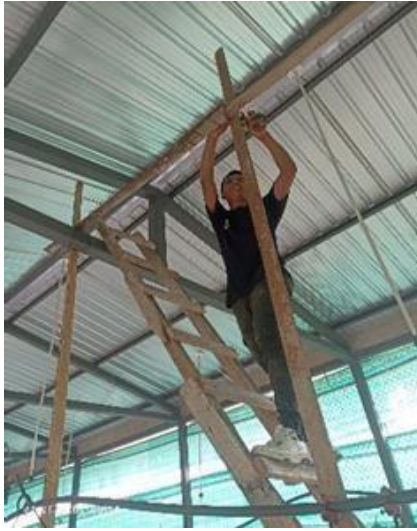
Figura 1A. Construcción del galpón.
