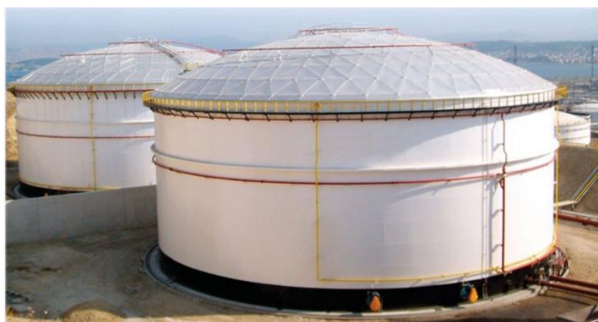
Gráfica 4. Tanque de techo fijo. (Rejiglass, s.f.)
