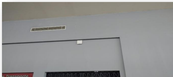
Figura 52. Colocación de equipo AP2 (TERMINAL-TERRESTRE-1)
