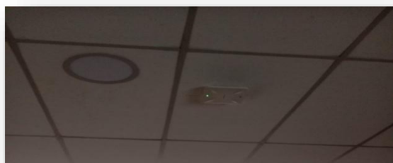
Figura 51. Colocación de equipo AP1 (TERMINAL-TERRESTRE-OFI)
