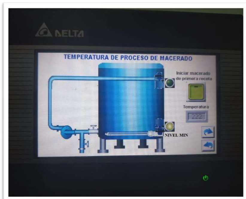
Figura 79. HMI llenado de agua activación de sensor de nivel bajo.
