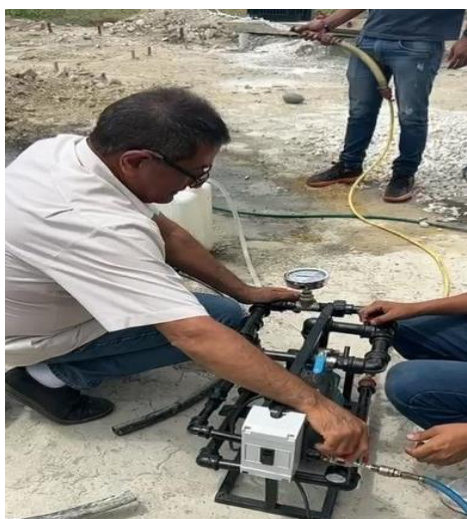
Figura 30: Descarga y control de la espuma generada.
