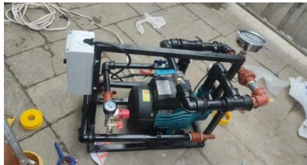
Figura 25: Montaje y soldadura del prototipo
