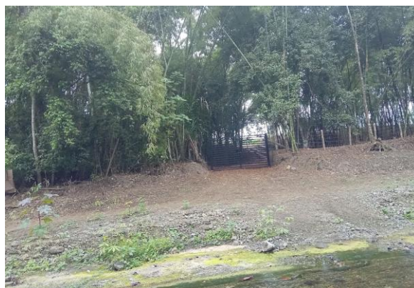
Anexo 3. Degradación de la ribera, zona intervenida
