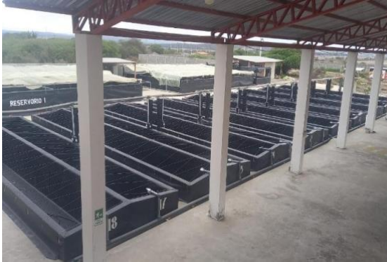
Figura 18: Tanques de producción
