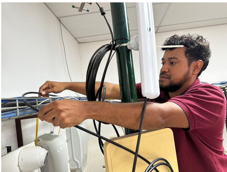
Figura 106. Colocación del cable Ethernet para la antena sectorial.
