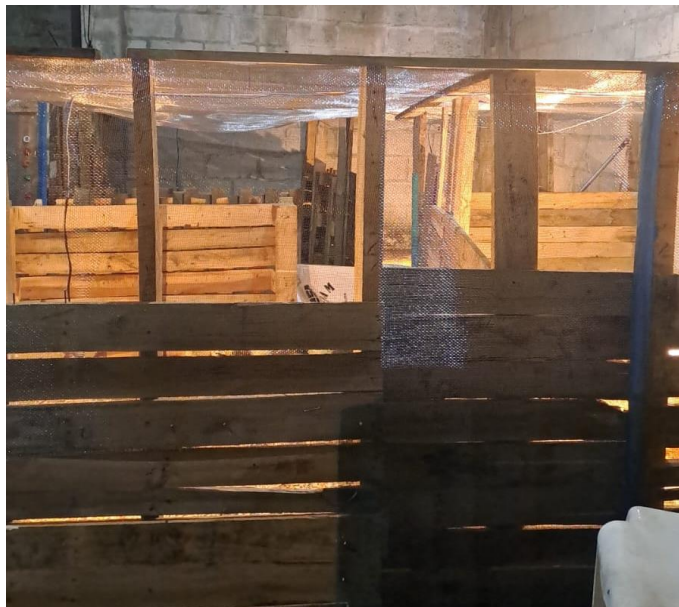
Figura 2A. Estructura del galpón
