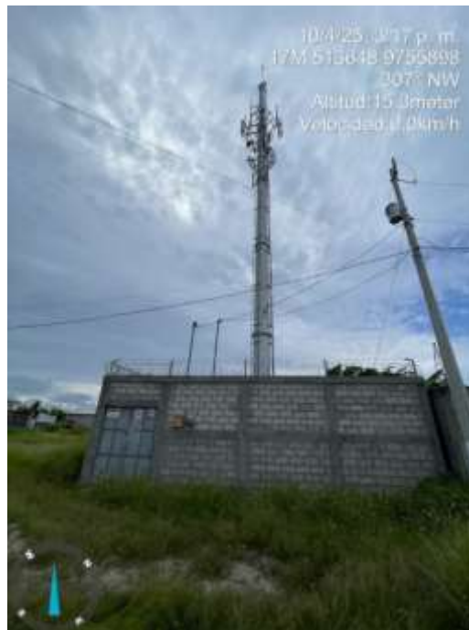
Figura 58: Fotografía del entorno zona costera
