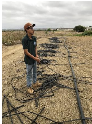
Figura 3A. Instalación de las líneas de riego
