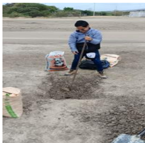
Anexo 3 Extracción de la tercera calicata en la vía de estudio
