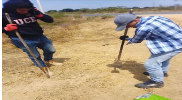
Anexo 2 Extracción de la segunda calicata en la vía de estudio
