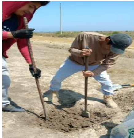
Anexo 5 Extracción de la quinta calicata en la vía de estudio
