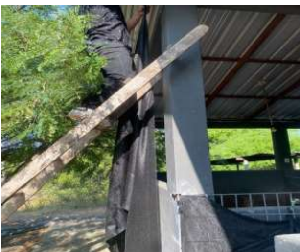
Figura A 1. Acondicionamiento de instalaciones
