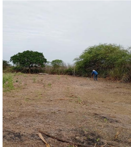
Figura 2A. Levantamiento del cercado.
