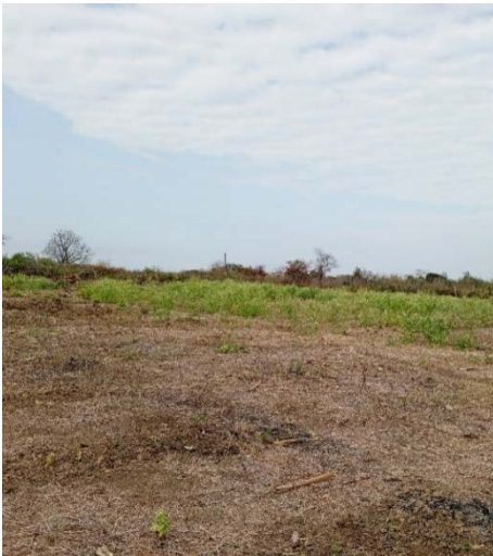
Figura 3A. Limpieza del terreno.
