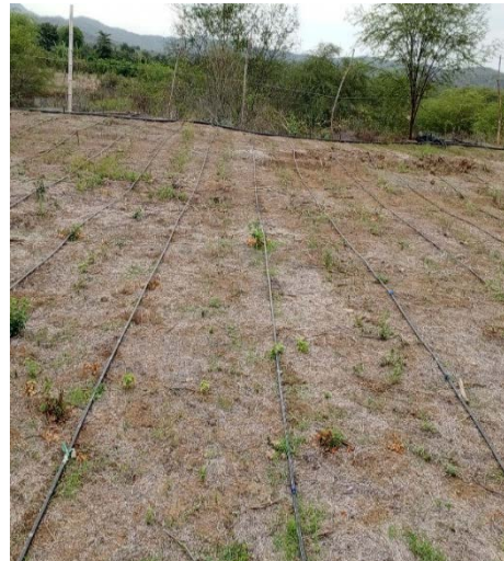
Figura 4A. Instalación de cintas de riego.
