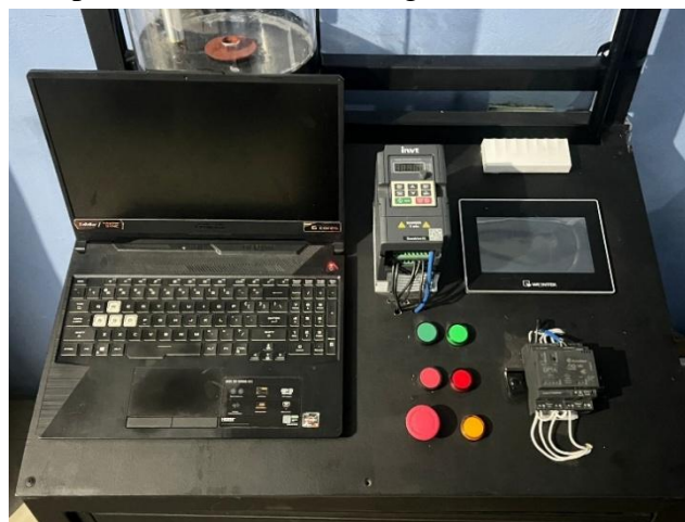
Figura 31: Panel de control finalizado.
