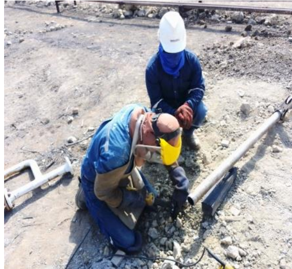
Figura 1. Corte de Tubería: Posturas Ergonómicas
