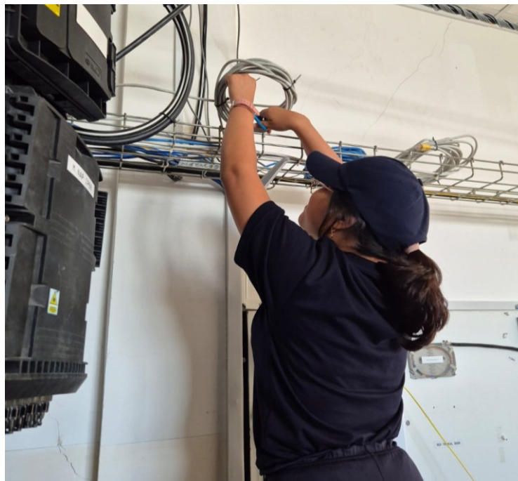
Anexo 2. Tendido de cable ethernet CAT6 para el laboratorio de Telecomunicaciones.
