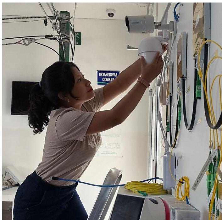
Anexo 5. Colocación de las cámaras de los módulos A, B y C.
