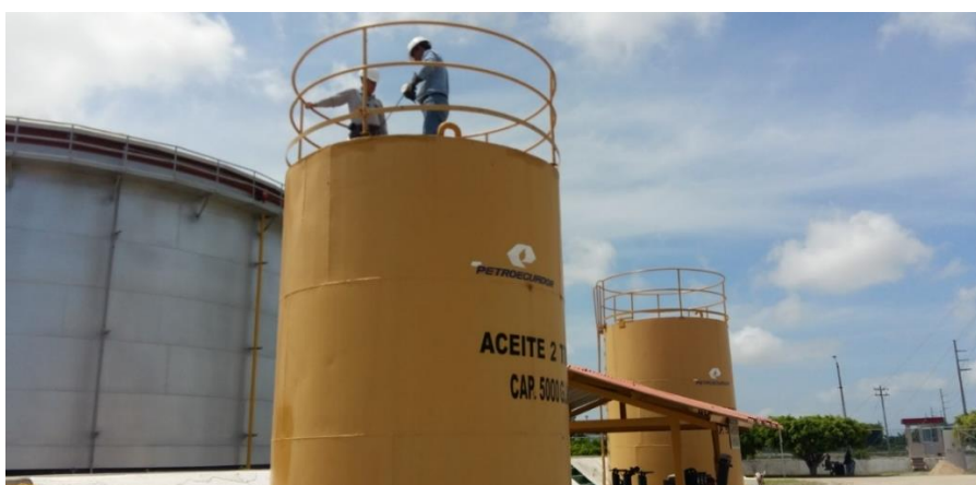
Figura N° 9 Aforo en los tanques de aceite de dos tiempos.
