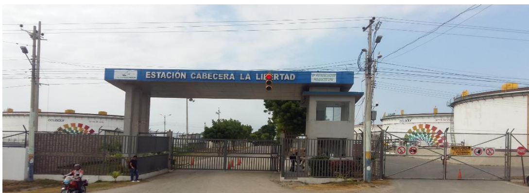
Figura N° 8 Estación Cabecera La Libertad
