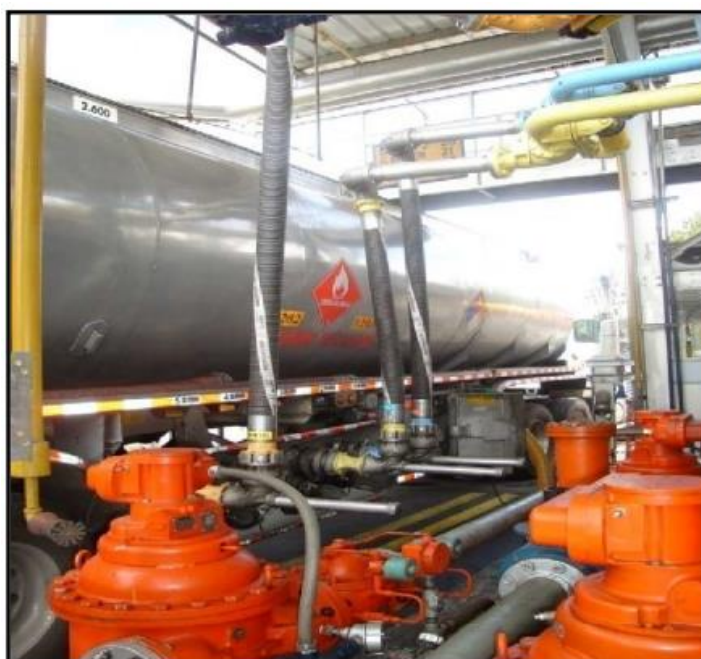
Figura N° 30 Sistema de Carga Ventral.
