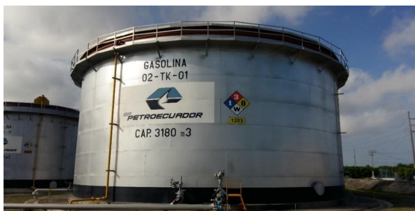
Figura N° 33 Tanque flotante TK-01 de almacenamiento de gasolina base.
