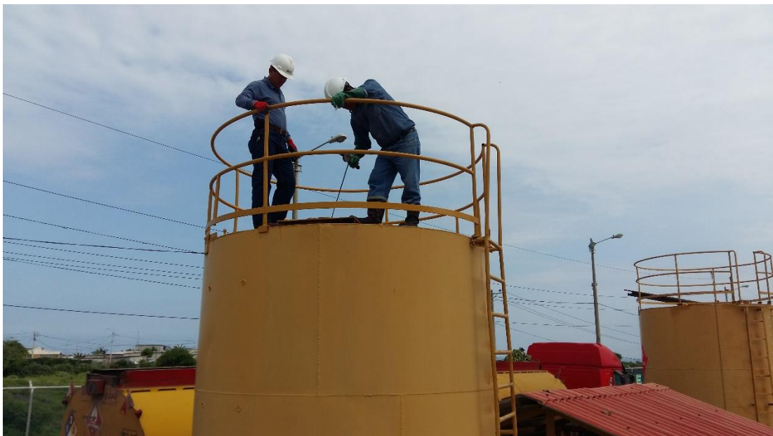
Figura N° 40 Aforo a los tanques de aceite de dos tiempos.
