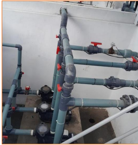
Figura 9 Estaciones de bombas
