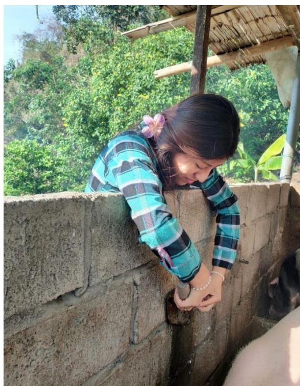
Figura 2A. Instalación de bebederos automáticos
