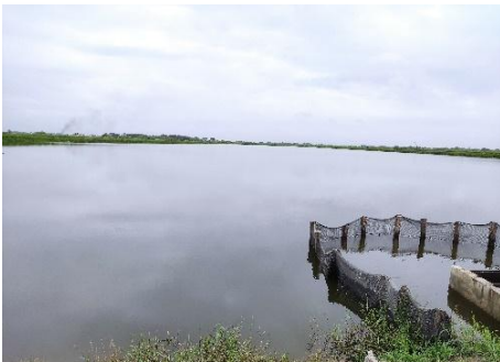
Anexo 3: Llenado de piscina.
