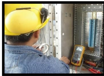
Imagen 3.8. Prueba de megado del cable
