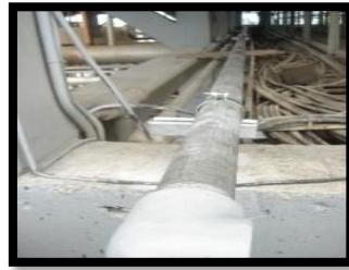
Imagen 3.4. Montaje de tubería
