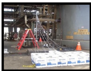
Imagen 3.5. Tendido de cable en las áreas
