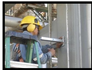
Imagen 3.2. Montaje de soportería
