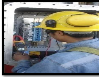
Imagen 3.7. Prueba de continuidad del cable
