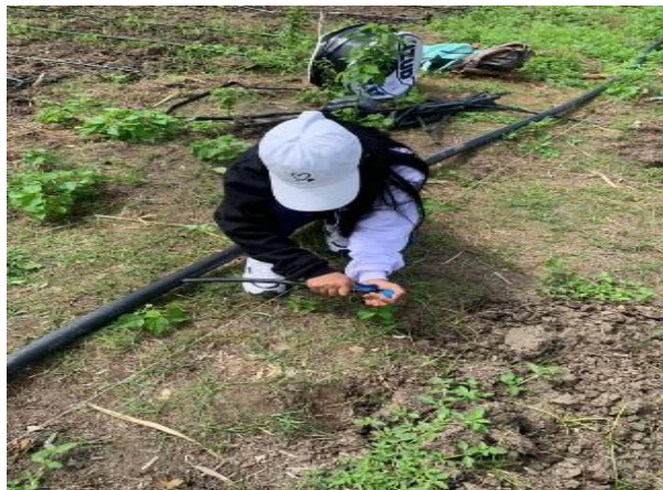
Anexo 0.24 "Instalación del sistema de riego"
