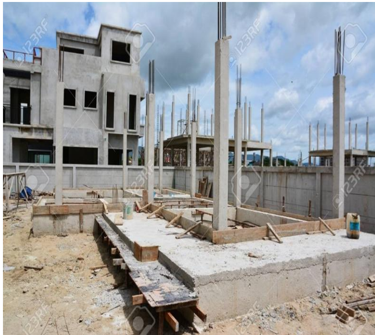
Ilustración 3. Estructura en construcción de hormigón armado con cimentación y columnas verticales en proceso de ejecución.
