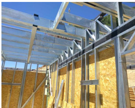
Ilustración 4. Estructura liviana tipo Steel Framing con perfiles de acero galvanizado y paneles OSB en proceso de montaje de muros y cubierta.
