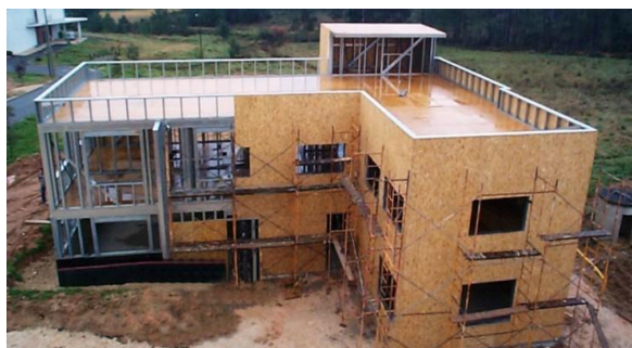
Ilustración 29. Construcción de Light Steel Framing.
